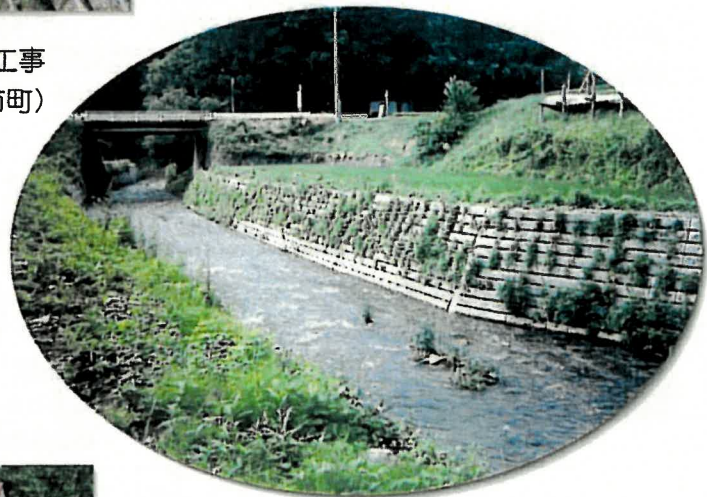
小井田川筋小井田地区河川災害復旧工事 (一戸町)
