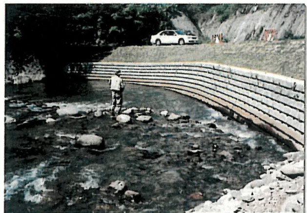
町道兄川線作平地区道路災害復旧工事 (安代町)
