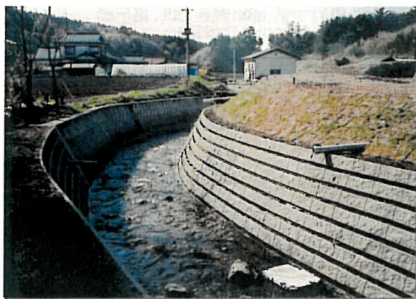
長興寺地区河川災害復旧工事 (九戸村)
