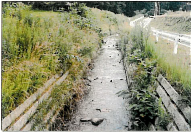
農業用施設災害復旧工事 (種市町)
