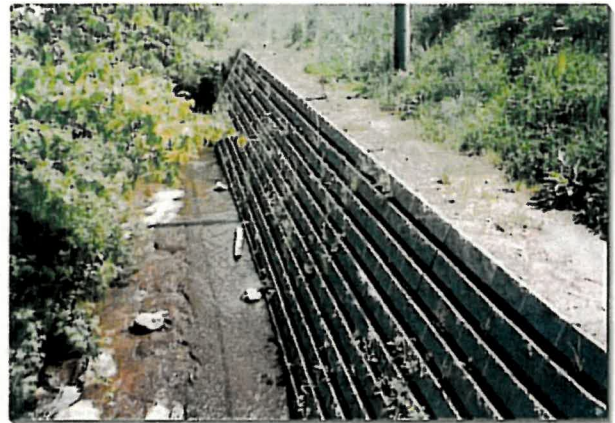
小雪屋河川災害復旧工事 (九戸村)
