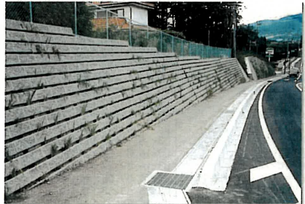
県道中込線道路改良工事 (小諸市)
