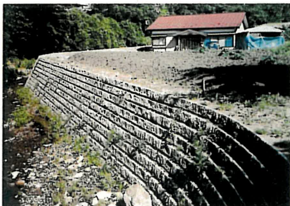
仁左平川筋矢沢地区河川災害復旧工事 (二戸市)
