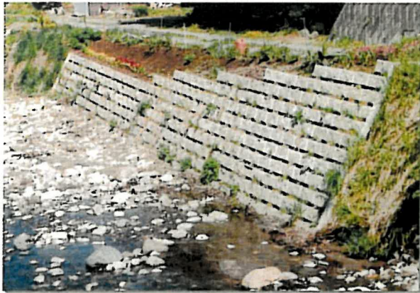
熊ノ沢川河川災害復旧工事 (十和田市)
