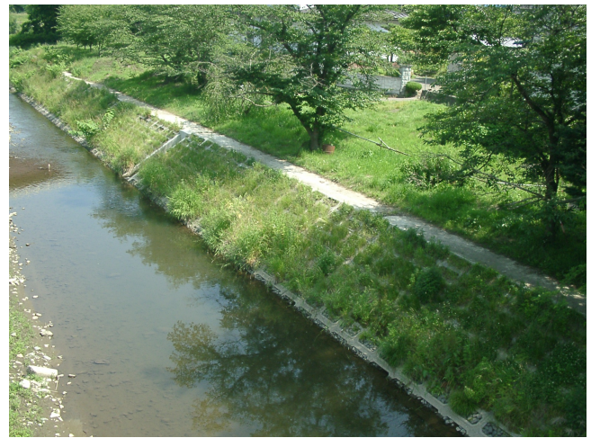
馬淵川筋府金橋上地区（二戸市）
