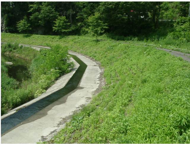
雪谷川筋軽米地区 4 工区（軽米町）
