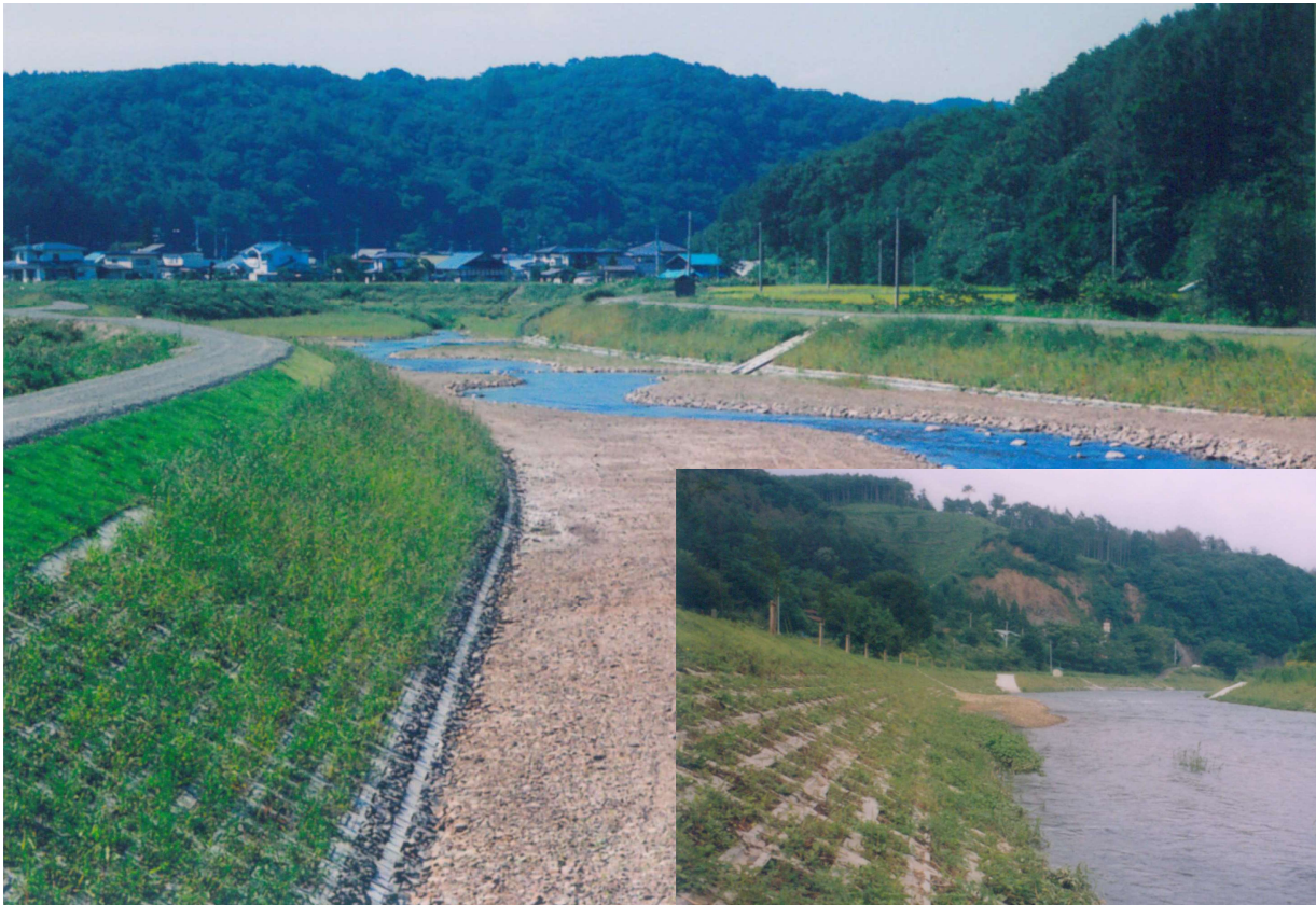
雪谷川筋軽米地区 12-1 工区（軽米町）
