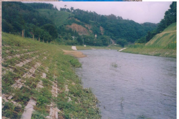
雪谷川筋軽米地区 7 工区（軽米町）
