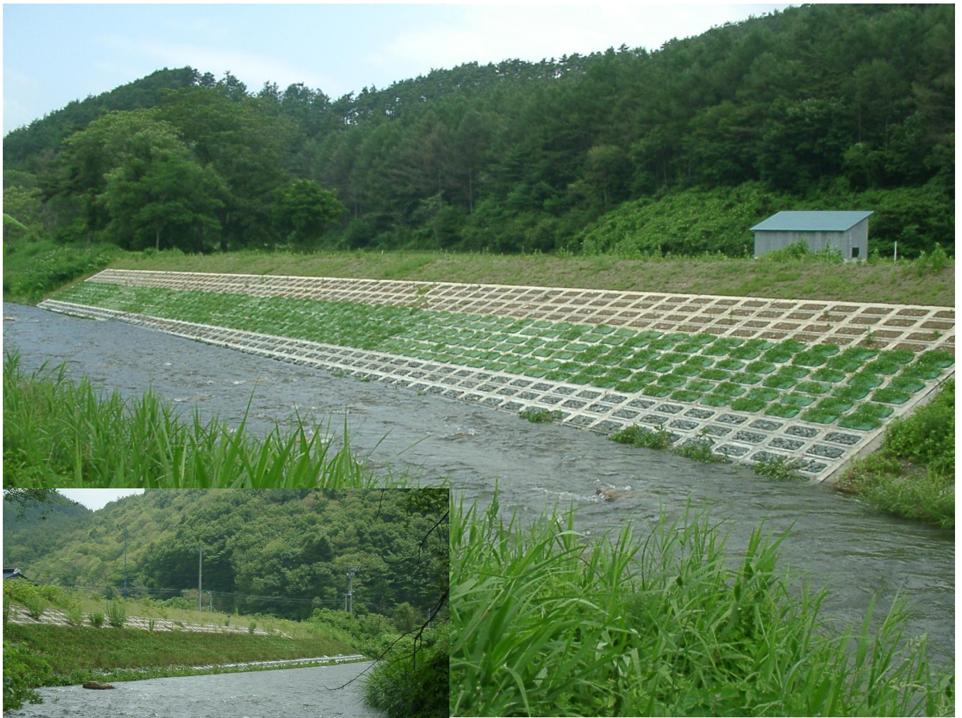
瀬月内川筋倉野橋下地区（九戸村）
